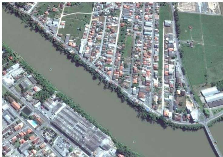
Figura 26 - Mostra a ocupação dos 30 metros ao longo do Rio Itajaí Açú, bairro Margem Esquerda e Coloninha, acima Rua Luiz Franzoi e abaixo Indústria Círculo S/A
