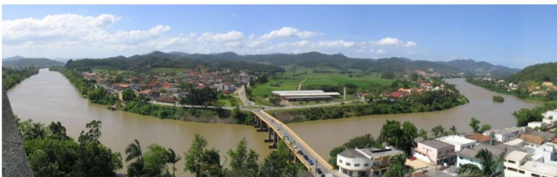
Figura 25 - Mostram os 15 metros ocupados apenas pelas cabeceiras da ponte Hercílio Deeke, Centro e descida para o rio.
