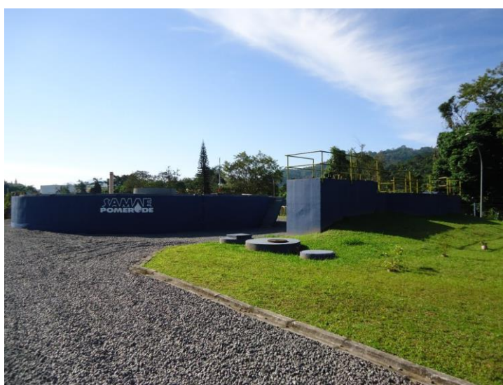
Figura 38 - Estação de Tratamento de Esgoto do Município de Pomerode
