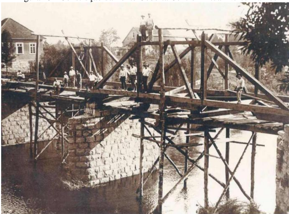
Figura 15 - Construção da Ponte Coberta Centro - Atual Nereu Ramos
