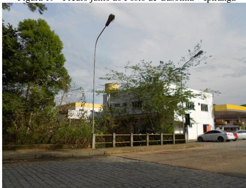
Figura 19 - Prédio junto ao Posto de Gasolina – Ipiranga
