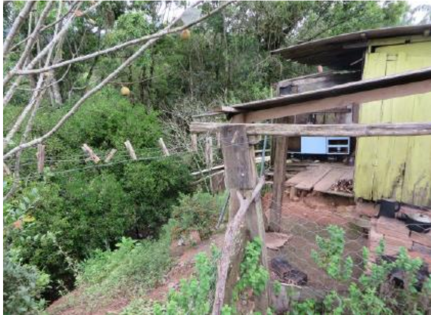
Figura 37 – Residência com risco de deslizamento
