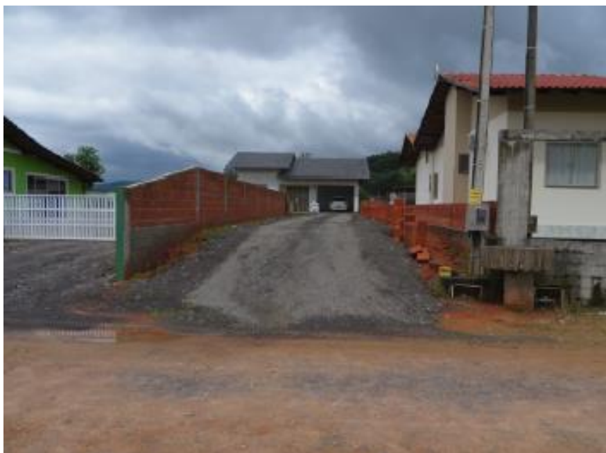
Figura 33 – Residência construída sobre aterro
