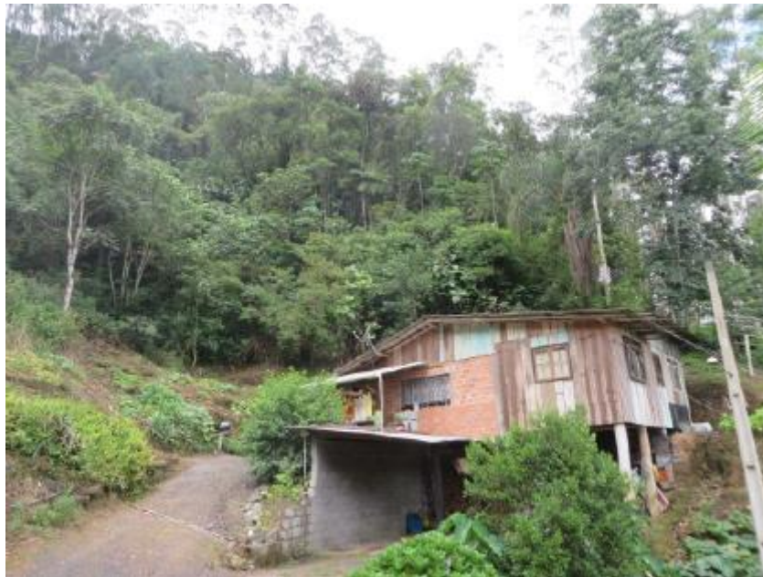
Figura 38 – Residência localizada em alta declividade
