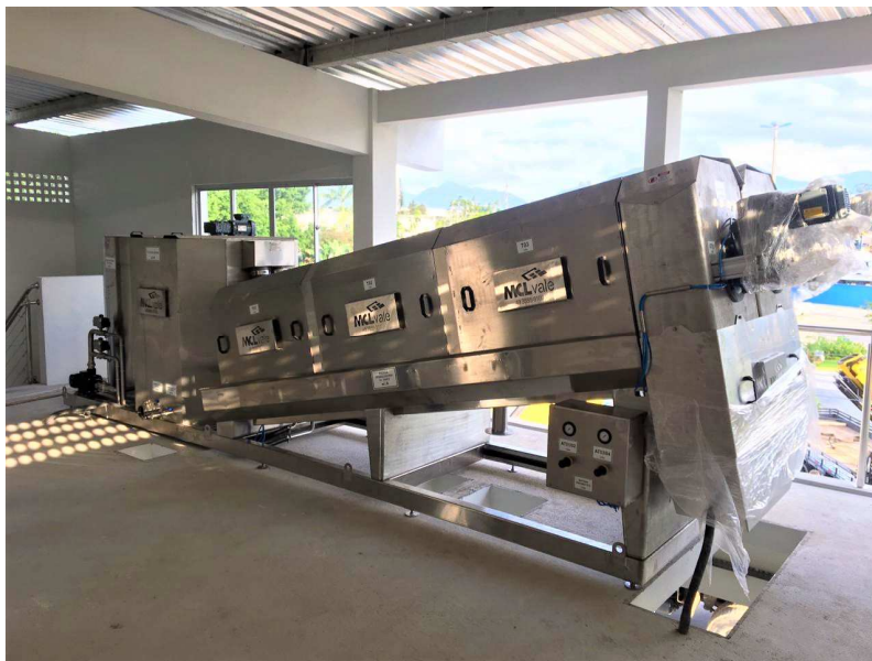
Sistema Integrado Megapress 15m 3 /h – Estação Águas Verdes
