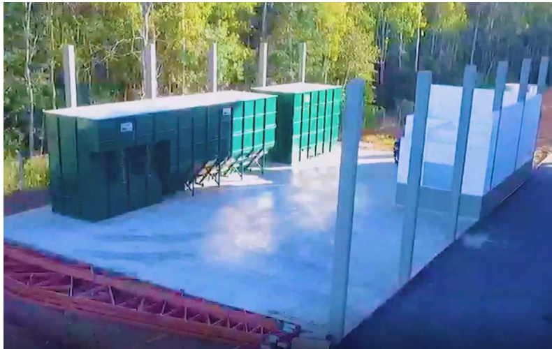
ETA em fase de montagem
