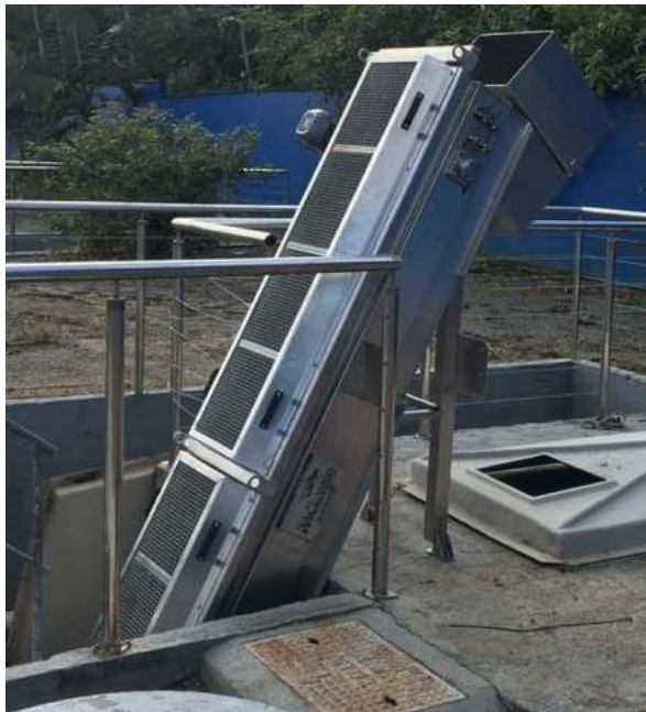
Gradeamento mecanizado para esgoto domestico - Estação Nereu Ramos
