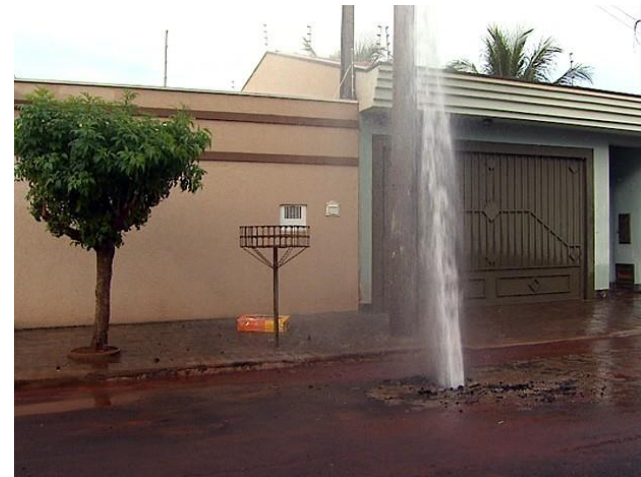
Vazamentos: rompimentos de tubulações
