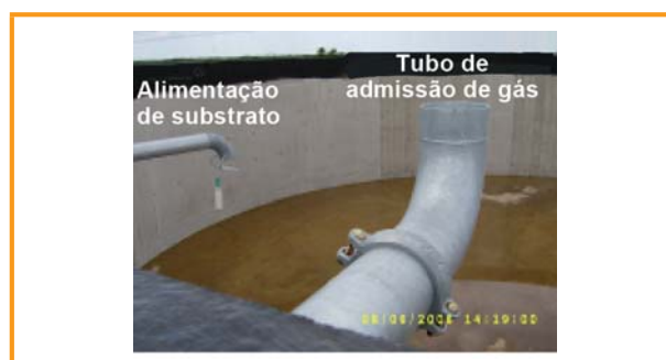
Figura 3.36: Dispositivos para transportar o gás sem distúrbios; tubo de admissão de gás com abertura voltada para cima (alimentação de substrato à esquerda) [DBFZ]
