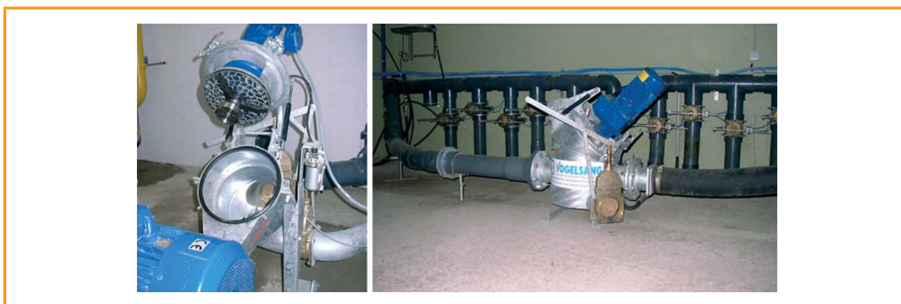
Figura 3.8: fragmentação de substrato na linha de transporte (triturador de prato perfurado) [Hugo Vogelsang Maschinenbau GmbH]
