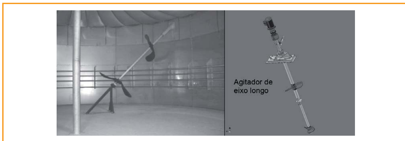
Figura 3.32: Agitadores de eixo longo com dois dispositivos de agitação, com e sem apoio no fundo do biodigestor [WELtec BioPower GmbH; desenho: Armatec FTS-Armaturen GmbH & Co. KG]
