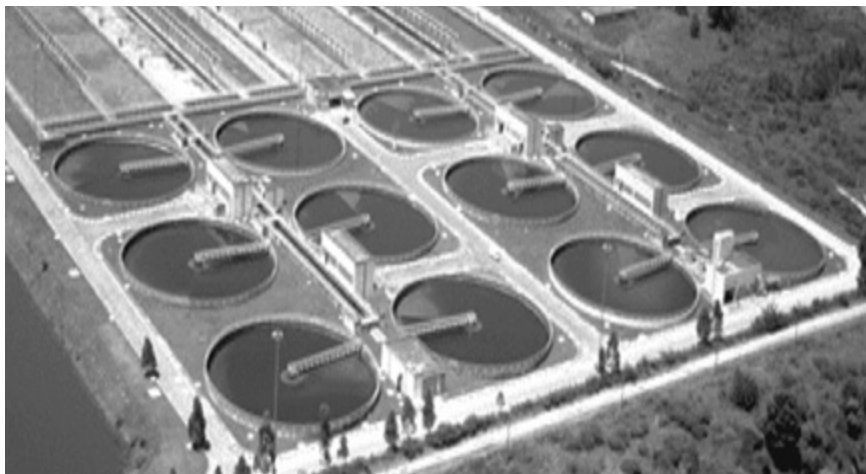
ILUSTRAÇÃO 3.5.3.2 – ETE LODOS ATIVADOS BEM OPERADA
