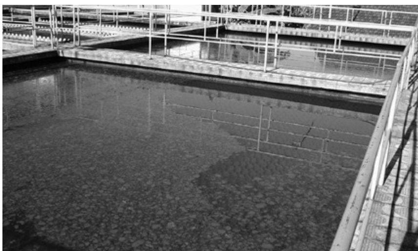
ILUSTRAÇÃO 3.5.2.20 – DECANTADOR COM FLOCOS FLUTUANTES
