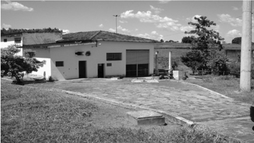
ILUSTRAÇÃO 3.5.2.9 – ESTAÇÃO ELEVATÓRIA DE ÁGUA BRUTA
