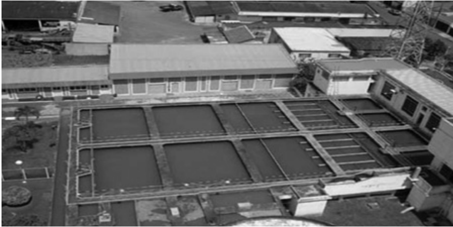
ILUSTRAÇÃO 3.5.2.21 – ETA CONVENCIONAL DE CICLO COMPLETO
