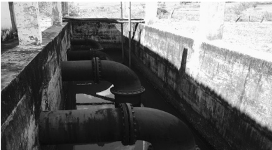
ILUSTRAÇÃO 3.5.2.10 – TUBULAÇÕES DE SUCÇÃO
