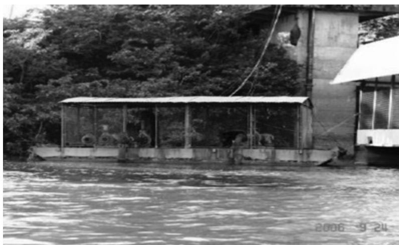
ILUSTRAÇÃO 3.5.2.6 – CAPTAÇÃO FLUTUANTE
