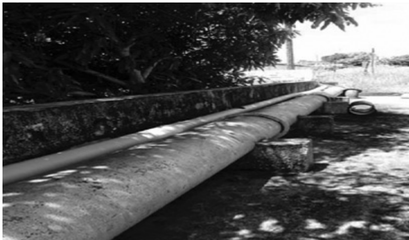
ILUSTRAÇÃO 3.5.2.8 – ADTORA DE ÁGUA BRUTA
