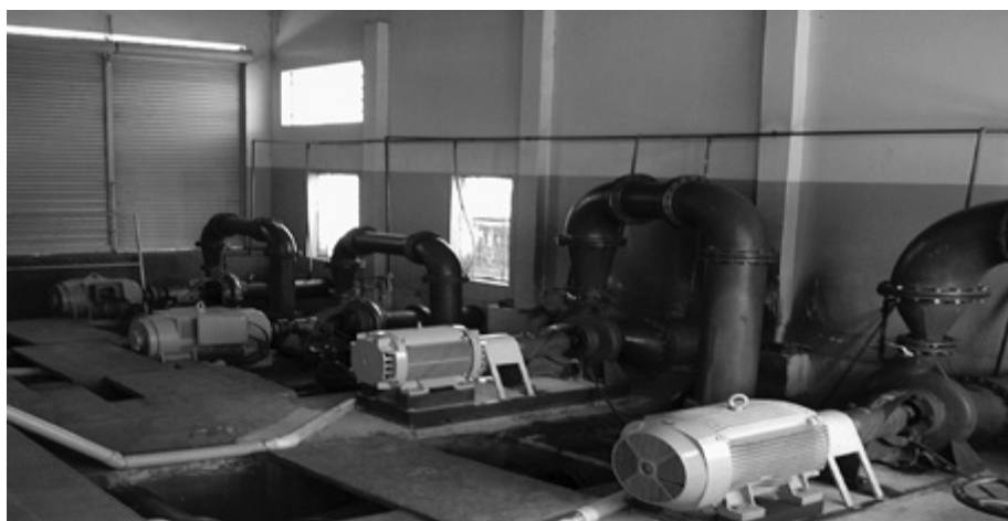
ILUSTRAÇÃO 3.5.2.12 – NOVOS CONJUNTOS ELEVATÓRIOS PARA REDUÇÃO DE ENERGIA ELÉTRICA
