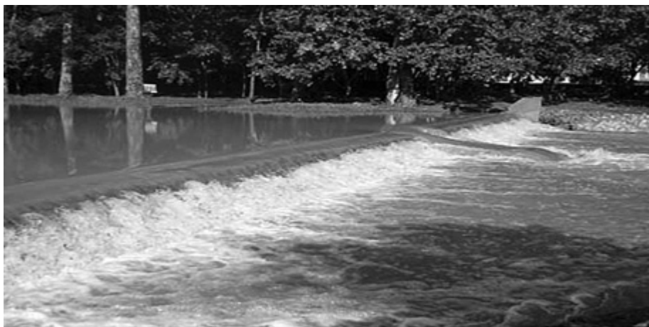
ILUSTRAÇÃO 3.5.2.5 – BARRAGEM DE NÍVEL – CAPTAÇÃO BEM OPERADA
